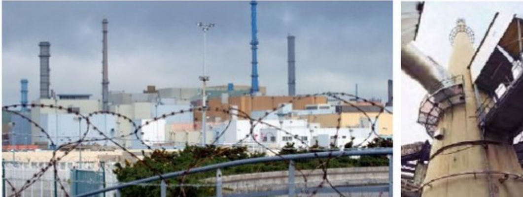
Fig. 5. Les cheminées de Areva/CEA La Hague, les deux étroites hautes de 100 m pour UP2-800 (gros plan à droite), et UP3 (bleue), diamètre à l'émission 2,75 m, débit chacune : 790 000 m 3 /h (ph. inconnu et Areva)
