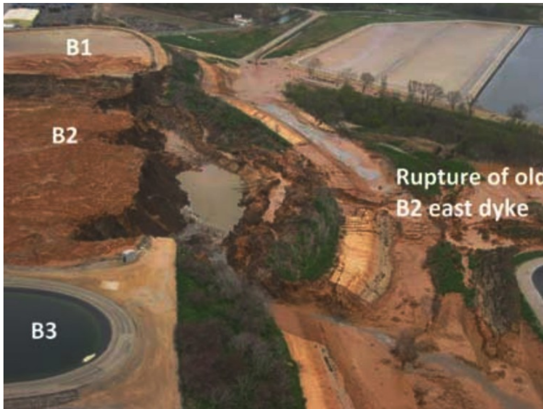
Fig. 27. La digue effondrée du bassin B2 en mars 2004, eau, gadoue et ruissellement notamment de ce qui est du déchet FAVL ( in Fernandes 2017)
