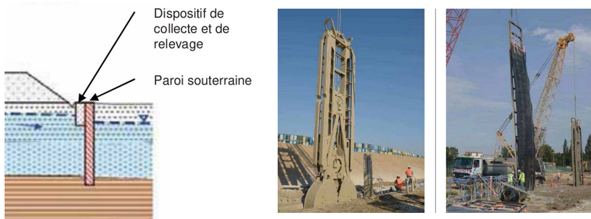
Fig. 33. Parois de blocage de la nappe phréatique installée en 2012-13 sur la hauteur des alluvions quaternaires à l'Est du massif B1/B6. Selon ce schéma ces "parois au coulis" vont jusque dans l'Oligocène sous-jacent, à propos duquel il est écrit : " Substratum Oligocène avec passées sableuses parfois humides ". Elle sont doublées en amont hydraulique d'un "fossé de contrôle avant parois" (Areva 2013, p. 184, 233-4).
