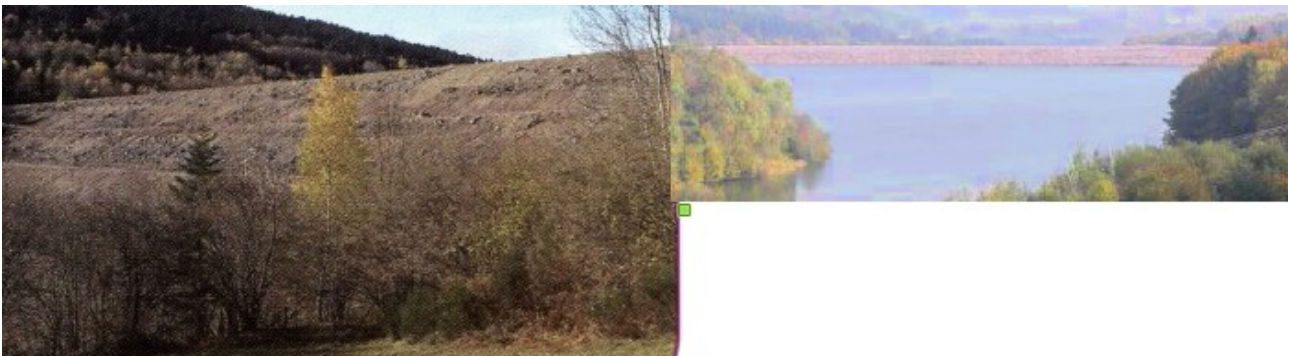
Fig. 4. A St Priest-la-Prugne (Loire) : digue haute de 42 m, longue de 508 m derrière laquelle se trouvent 1,3 millions de tonnes sur 20 ha, cachés sous une lame d'eau épaisse de 2-3 m. La vallée du ruisseau a été bouchée par une digue et remplie de ces déchets. Dans la zone où s'échappe l'eau, les plantes aquatiques sont tellement contaminées (300 000 bq/kg-sec en Ra 226) qu'on peut les qualifier de déchets radioactifs, idem pour les poissons "au radium" dans la lame d'eau de 2-3 m (TU CriiRad n°68, déc 2015, là )
